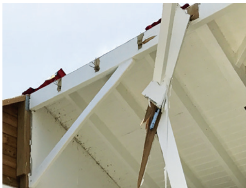
Figure 5 : Mauvais assemblage
