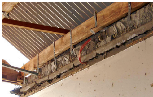
Figure 11 : Mauvaise fixation (plats mal ancrés)
