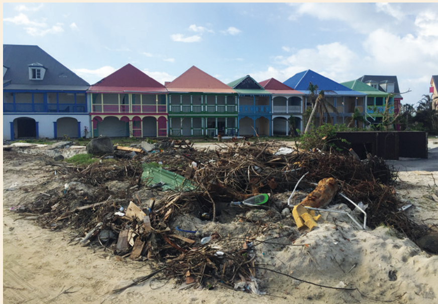
Figure 1 : Charpentes en site exposé ayant résisté
