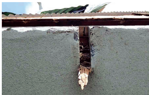
Figure 10 : Mauvaise fixation de la charpente au chaînage
