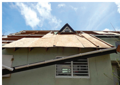
Figure 3 : Espacement des pannes trop important
