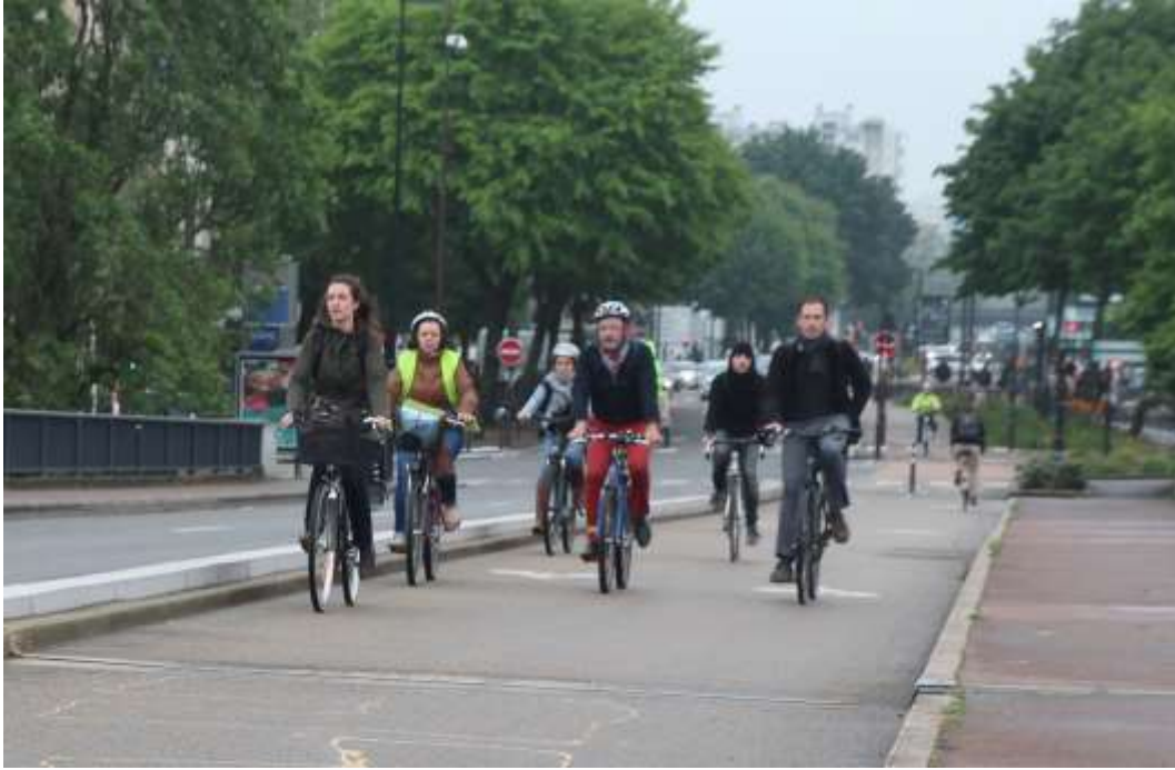
Nantes: piste cyclable bidirectionnelle bordant la chaussée générale
