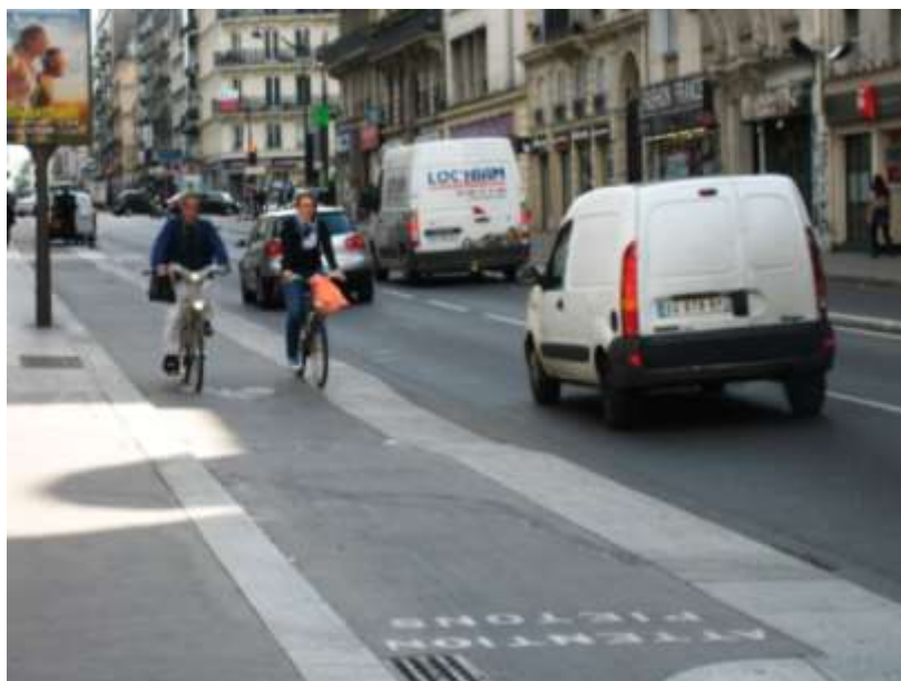
Paris: piste cyclable unidirectionnelle d'une largeur suffisante pour la circulation des cyclistes à deux de front
