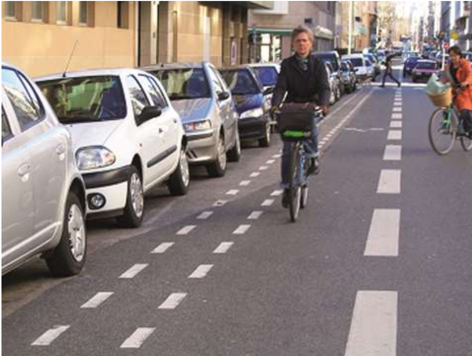
Bande cyclable avec espace tampon de 0,5 m
