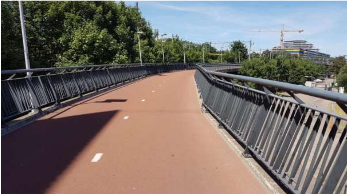
Figure 1 Nimègue, Pays bas: le garde-corps épouse la silhouette du cycliste et augmente ainsi la largeur roulable de la piste cyclable
