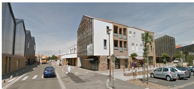
La continuité des espaces publics et de l'architecture à Bretignolles-sur-Mer
