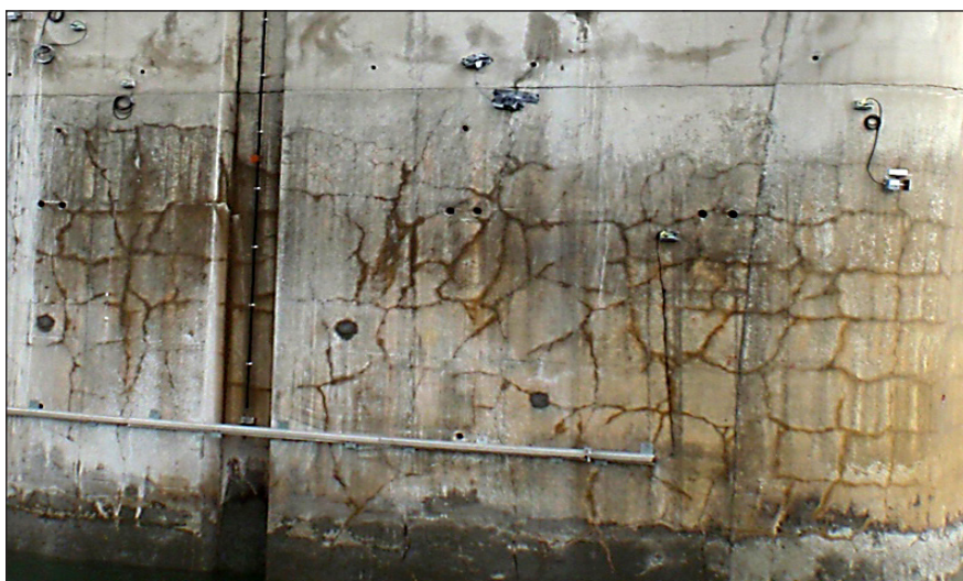
Dégradation d'un ouvrage, fissuration caractéristique en opus incertum (photo LERM)
