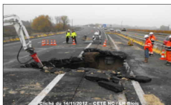
Effondrement karstique sur A71 PR100+900 – novembre 2012 (source : guide méthodologique cavités – à paraître)
