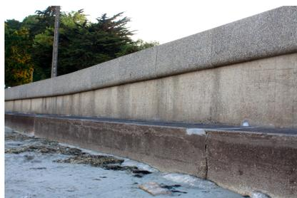
*Illustration 46 : Exemple d'un mur avec couronnement (Plouzané, 29)*
