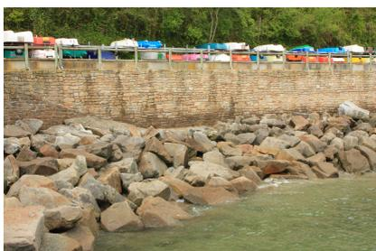
*Illustration 45 : Exemple d'un mur avec protection de pied anti-affouillement (Plouzané, 29)*
