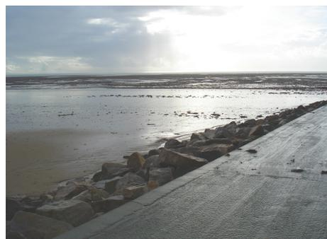
Illustration 19 : Cale de mise à l'eau avec protection anti affouillement en enrochements (Granville, 50)
