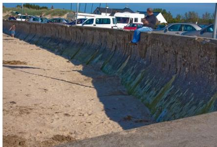
Illustration 7 : Perré en béton armé avec couronnement (Asnelles, 14)
