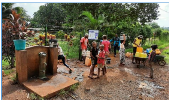
Borne-fontaine installée sur la commune de Kahani
